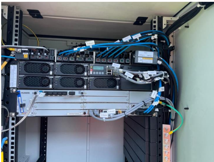
Figure 3: 5G SA RAN BBU Vlissingen
