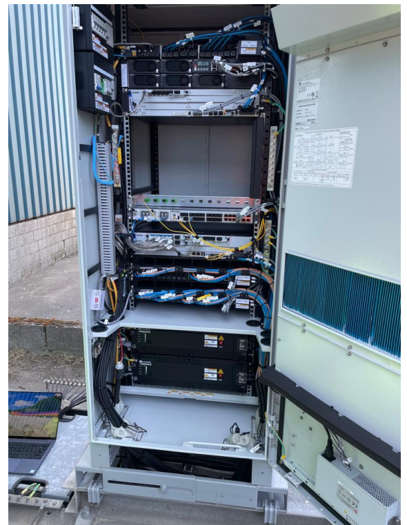
Figure 3: 5G SA RAN BBU Vlissingen
